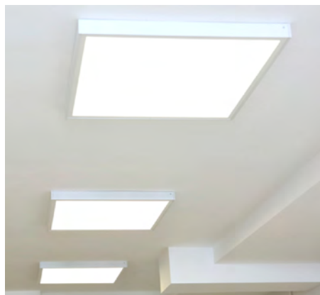
Lắp đặt ốp nổi
