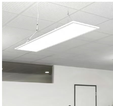
Lắp đặt thả trần
